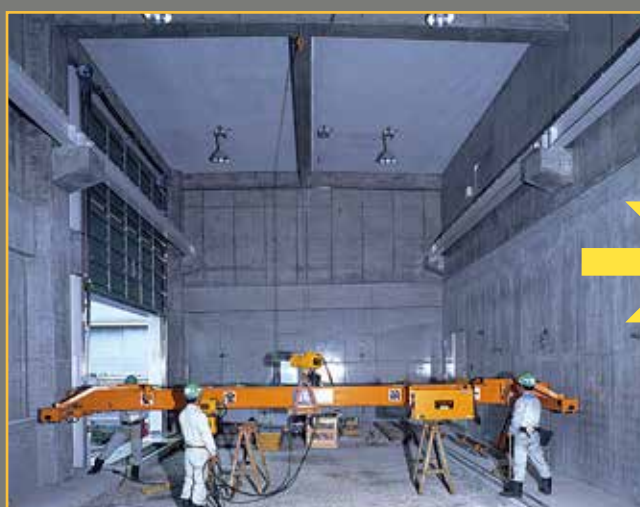
◎使用実例(1) 屋内クレーン設置作業
