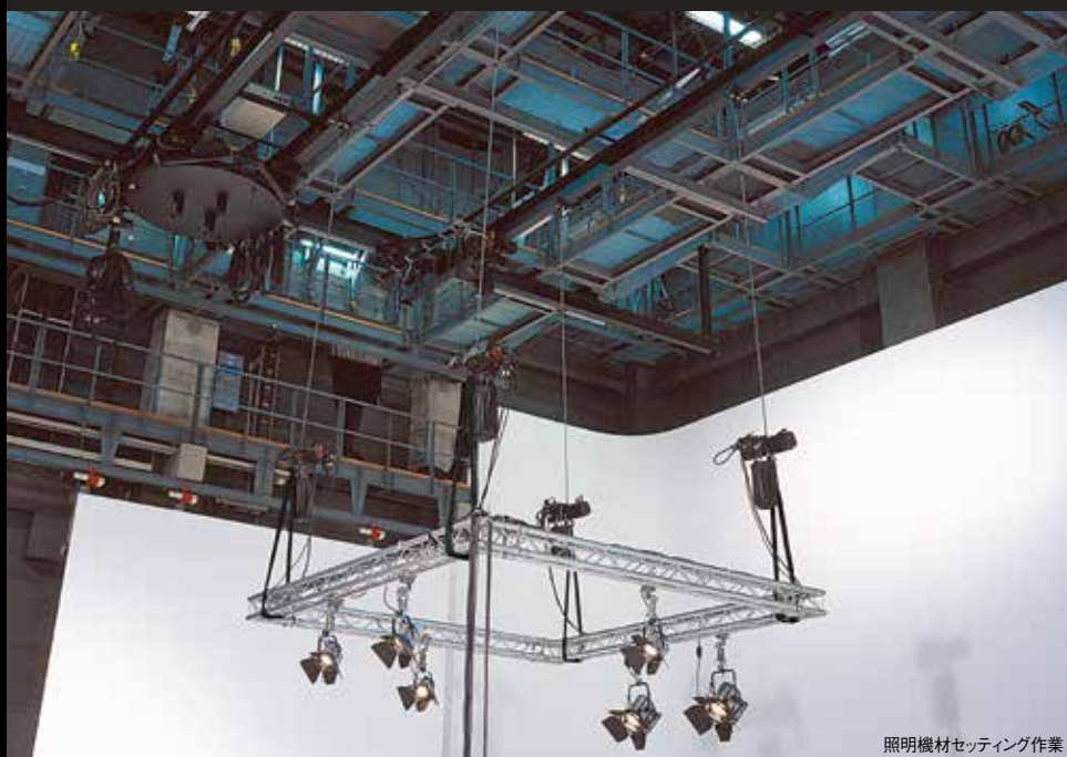
照明機材セッティング作業
