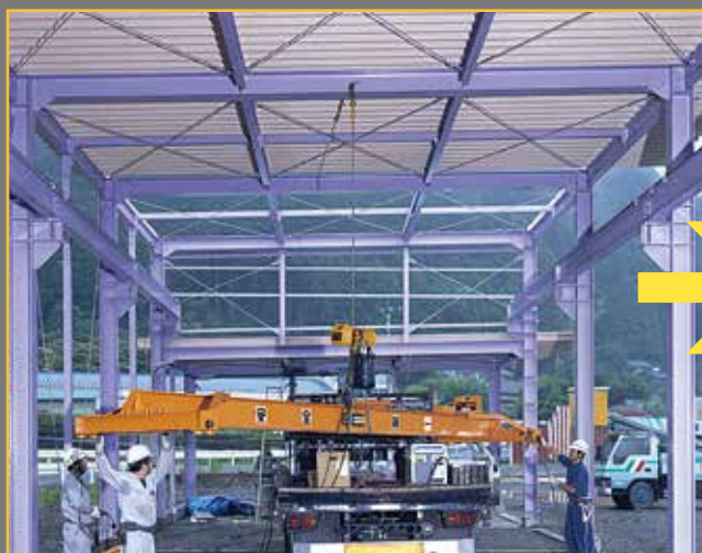
◎使用実例(2) 屋外クレーン設置作業
