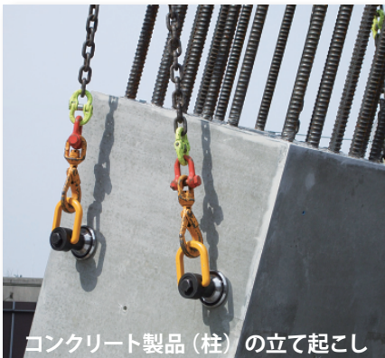
コンクリート二次製品の移動作業
